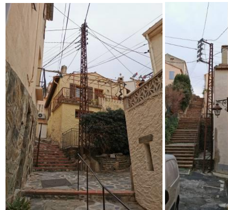
Poteaux en poutrelle d'acier au cap d'Oune
