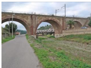
Le pont ferroviaire sur la Baillaury
