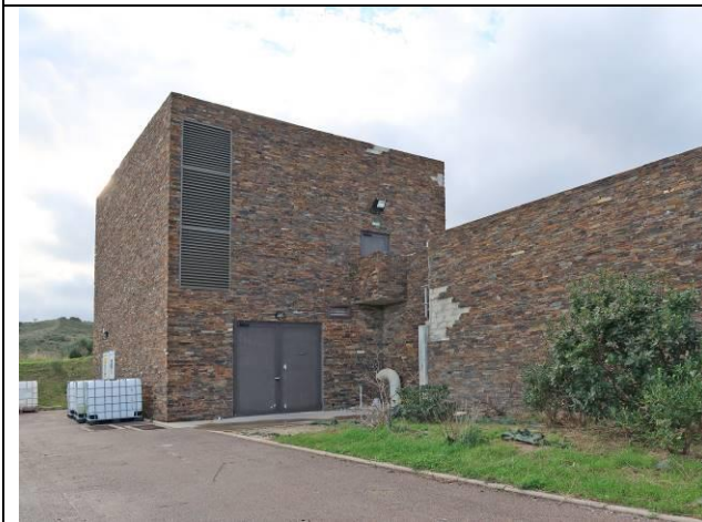
Station d'épuration. Le Pinell
